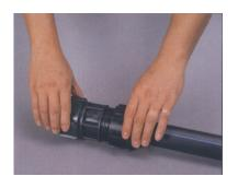
將接頭本體、管子、止水 O 型環、推進環、帽蓋等零件依圖示位置次序排列。塗上肥皂水或噴蠟增加其潤滑性。
